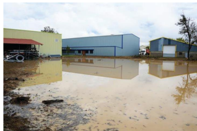
Zone industrielle basse du Pontet inondée par la remontée des eaux de l'Ozon en 2014 à Saint-Symphorien d'Ozon (Source : LE PROGRES)
