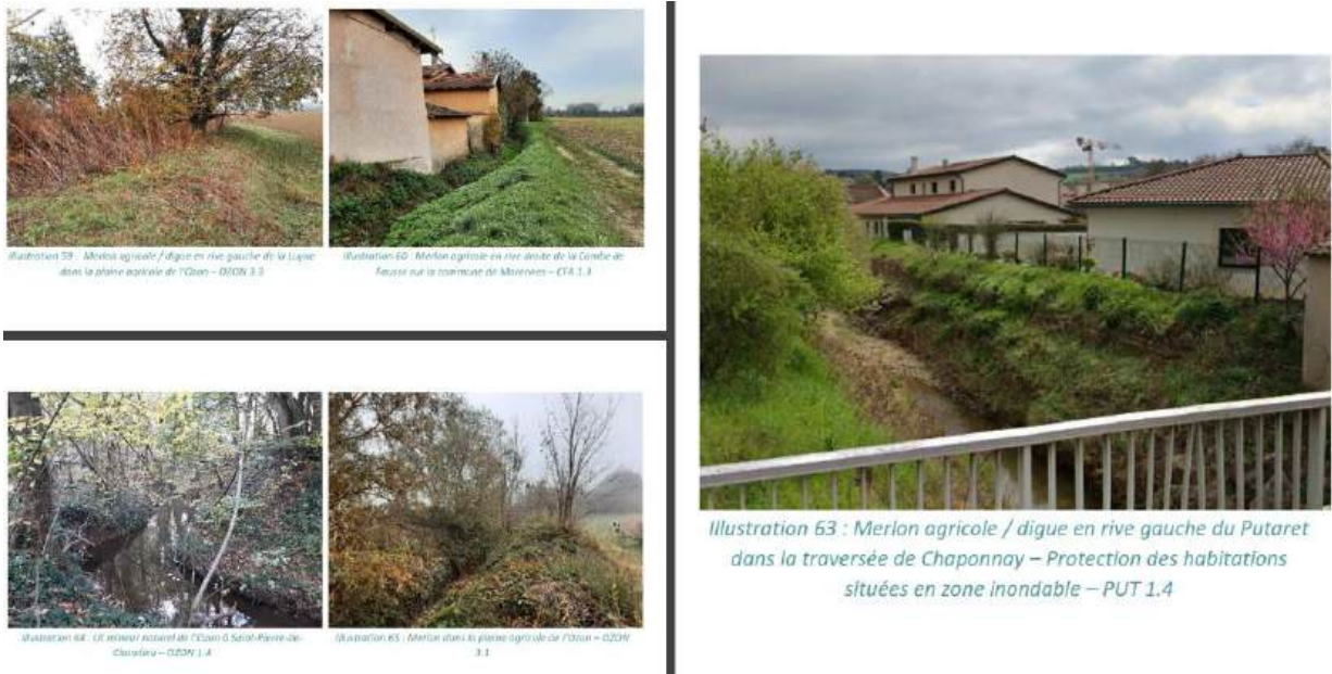
Figure 8 : Exemple de présence de merlons sur le territoire (CEREG, 2024)
