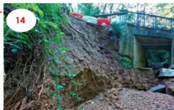
Figure 5 : Désordres constatés après la crue de 2018 (SMAVO, 2018 ; HTV, 2018)
