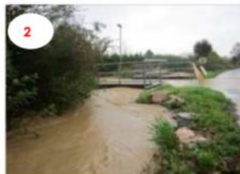
Rue inondée au pont de l'Oie
