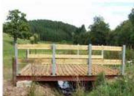
Passage en bois pour bétail et engins agricoles avec poutrelles métalliques et fondations en béton
