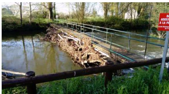
Chute d'arbres dans le cours d'eau pouvant former des embâcles en aval. (Photo : DDT41)
