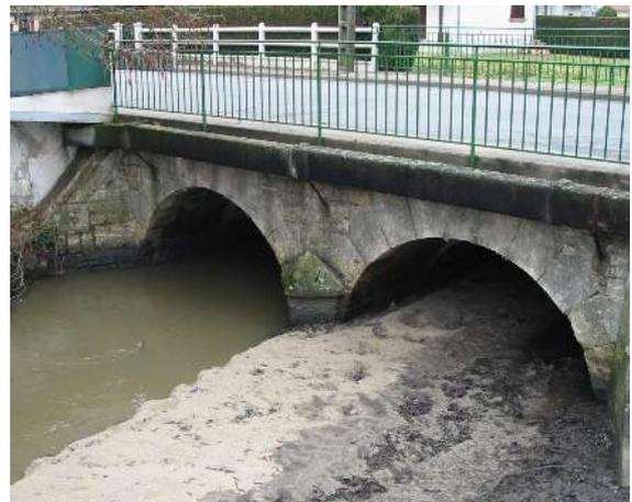
Atterrissement comblant partiellement une voûte de pont. (Photo : DDT41)
