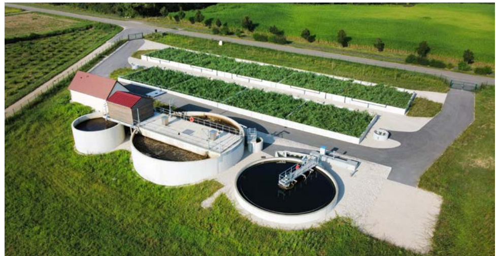
La station d'épuration de Montbarrey développe une capacité de 2700 équivalents habitants et assure le traitement des effluents de sept communes.
