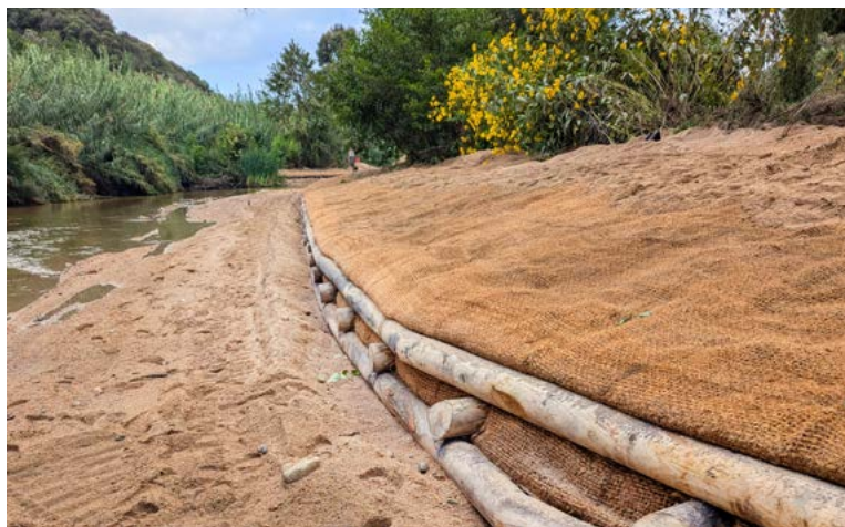
Pose de risbermes en bord de Prunelli. Ces banquettes formées par des caissons végétalisés stabilisent les berges.
