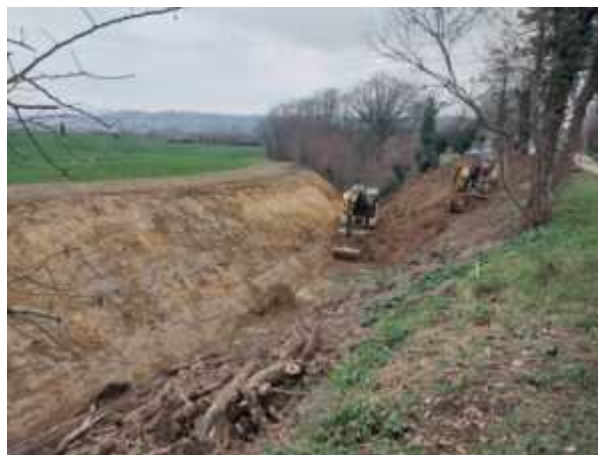
Pendant les travaux
